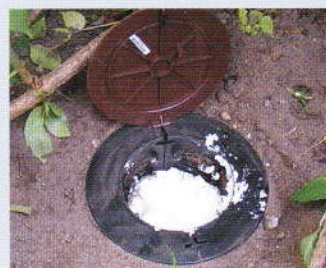
La station est entièrement remplie de formulation avant verrouillage.
